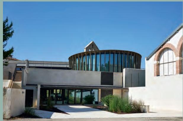
Façade arrière contemporaine
