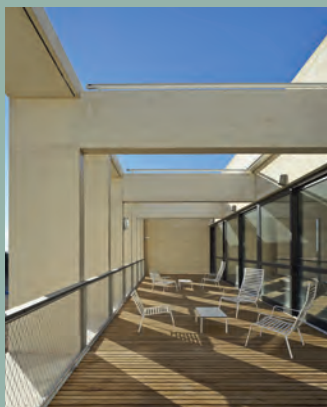
Espaces extérieurs avec les portiques brise-soleil
