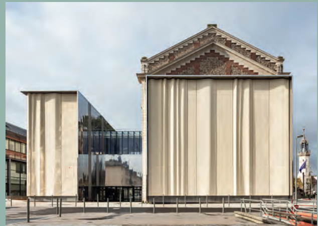
Traitement des façades arrières
