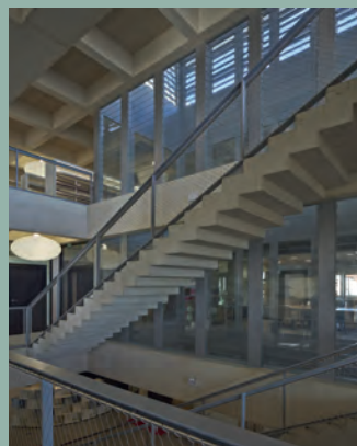
Circulations et vue en sous face des planchers caissons
