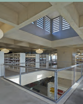
Puits de ventilation naturelle
