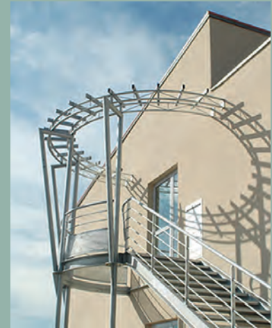
Détail de façade
